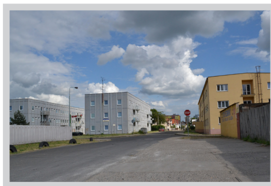
Ubytovny na Okružní ulici
