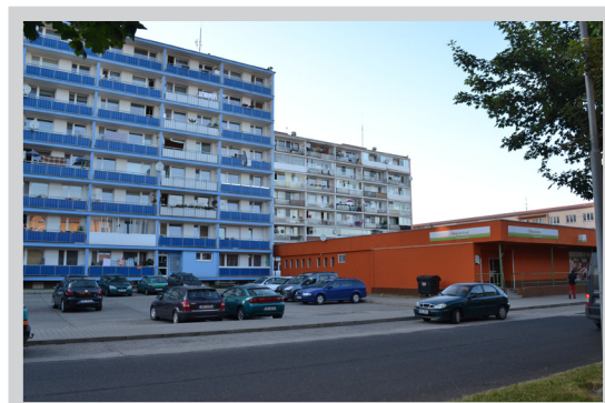
Panelová sídliště s vloženými objekty komerční a občanské vybavenosti
